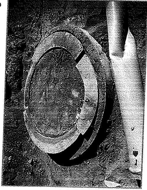
Foto N° 20: Cámara de Inspección N°14 (Av. Pedro Aguirre Cerda)
